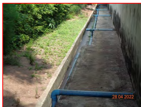
ภาพที่ 2.3-18 ท่อรวบรวมน้ำฝนปนเปื้อน บริเวณลานเก็บกองวัสดุ
